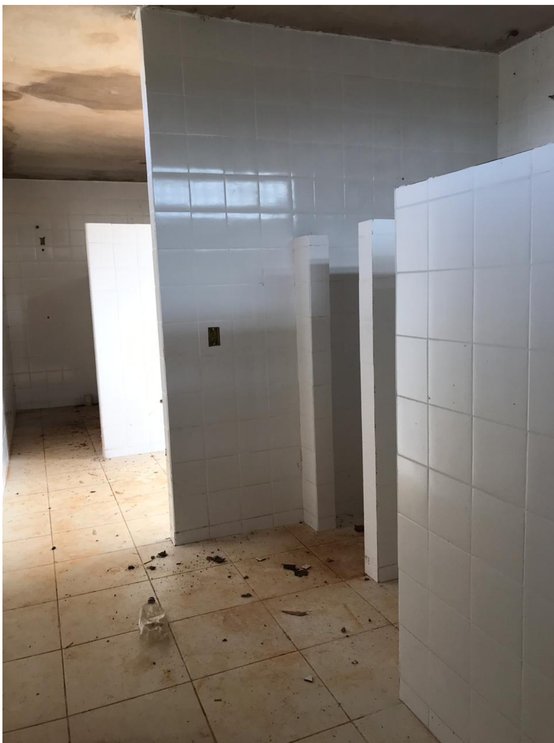
Foto 2: Box do sanitário/vestiário.
