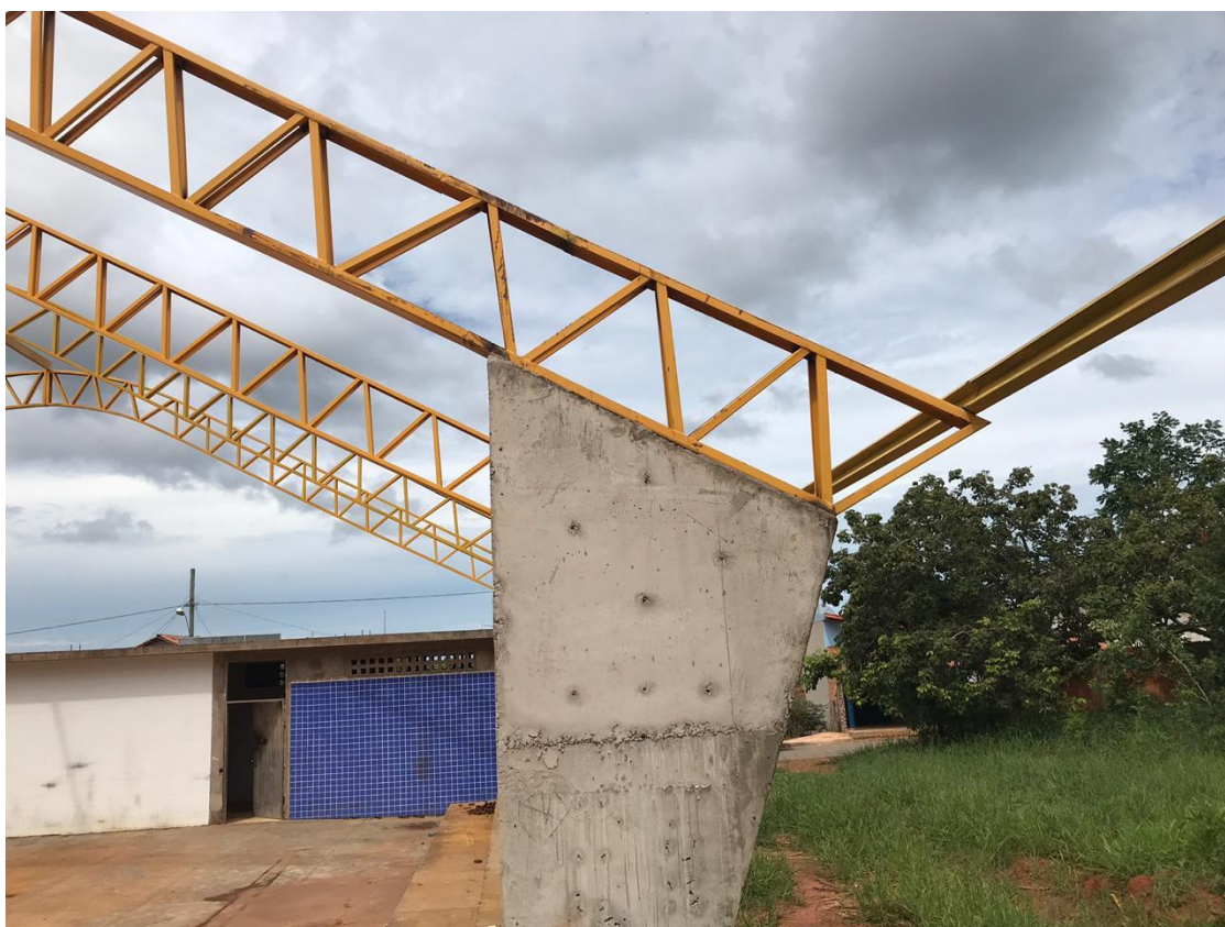
Foto 7: Superestrutura da quadra.
