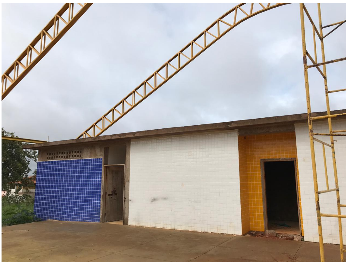
Foto 10: Revestimento do sanitário/vestiário.
