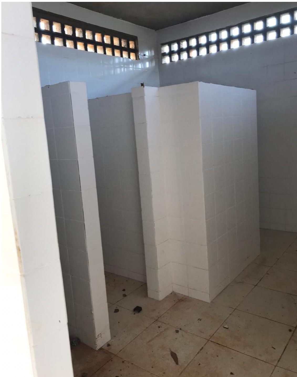
Foto 1: Box do sanitário/vestiário.
