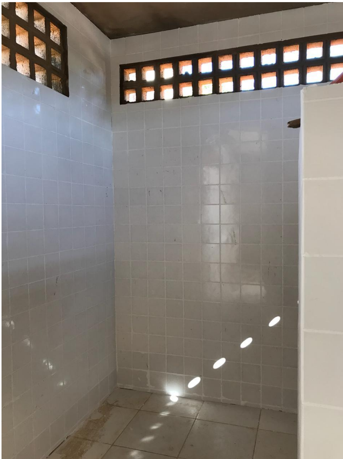
Foto 11: Revestimento do sanitário/vestiário.
