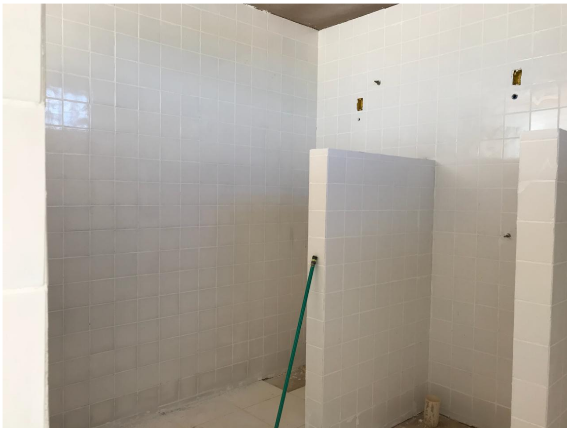
Foto 9: Box do sanitário/vestiário.
