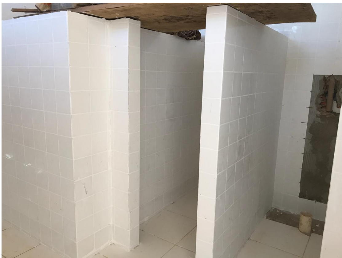
Foto 8: Box do sanitário/vestiário.
