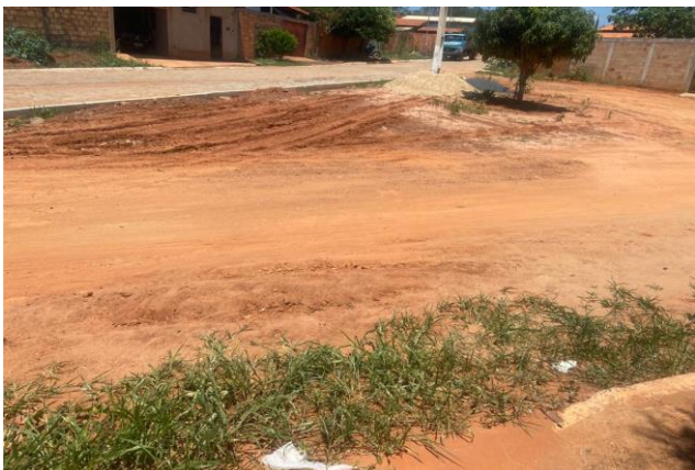
Localização da fotografia: RUA FELÍCIO BARBOSA - FOTO 9 Data da fotografia: 19/10/2023
