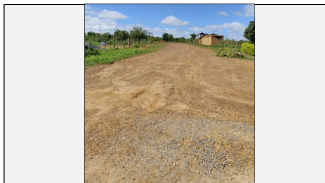
Localização da fotografia ESTRADA VICINAL BOA VISTA FOTO 20 Data da fotografia 22/11/2024
