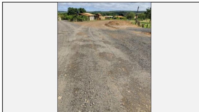
Localização da fotografia ESTRADA VICINAL BOA VISTA FOTO 18 Data da fotografia 22/11/2024
