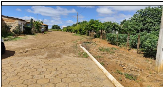
Localização da fotografia ESTRADA VICINAL BOA VISTA FOTO 21 Data da fotografia 22/11/2024
