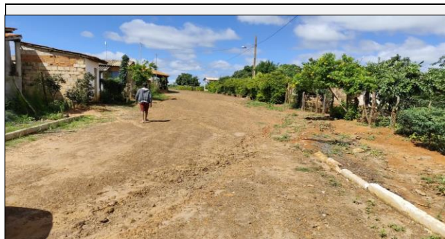
Localização da fotografia ESTRADA VICINAL BOA VISTA FOTO 22 Data da fotografia 22/11/2024
