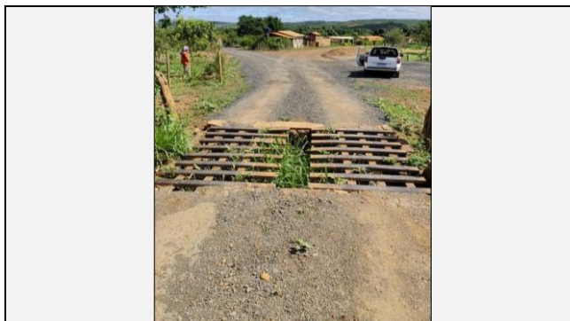
Localização da fotografia ESTRADA VICINAL BOA VISTA FOTO 17 Data da fotografia 22/11/2024
