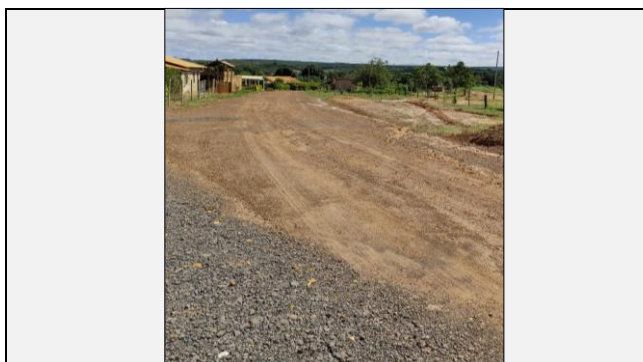
Localização da fotografia ESTRADA VICINAL BOA VISTA FOTO 19 Data da fotografia 22/11/2024
