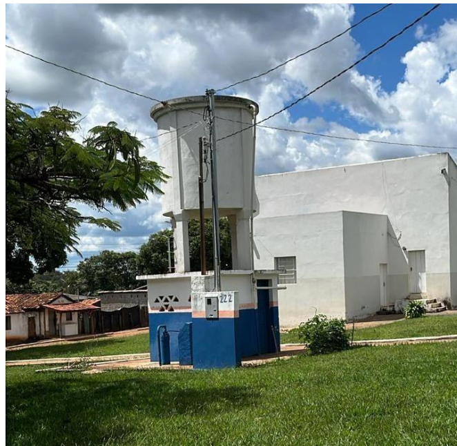
Figura 25: Reservatório de Água da Comunidade de São Roberto.
