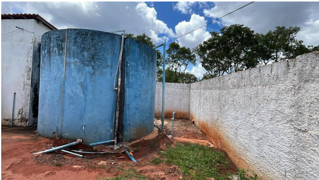
Figura 23: Reservatório da Estação de Tratamento de Água.
