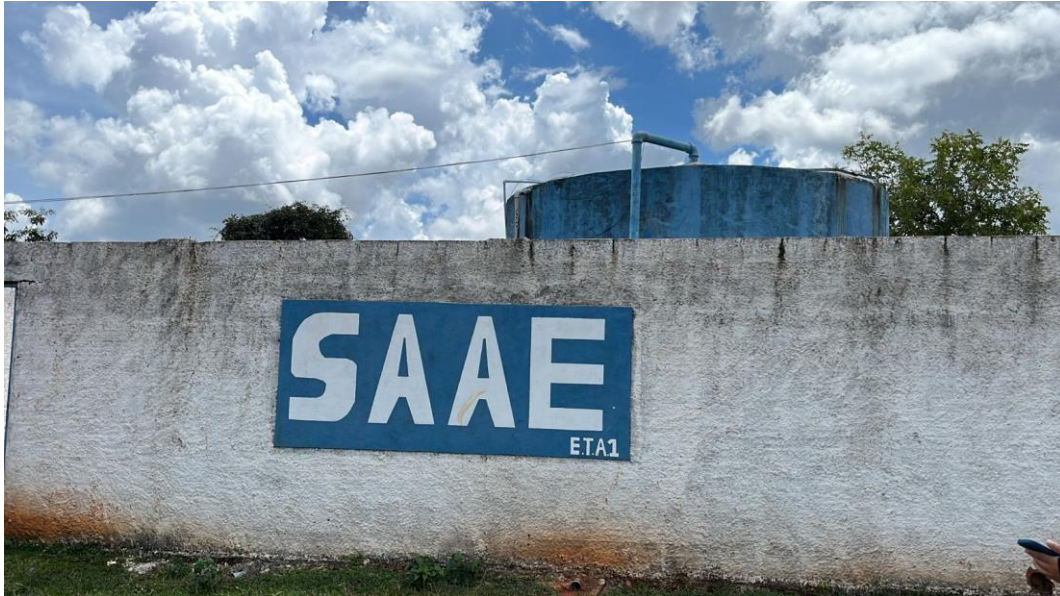
Figura 22: Estação de Tratamento de Água. Fonte: CODANORTE,2026
