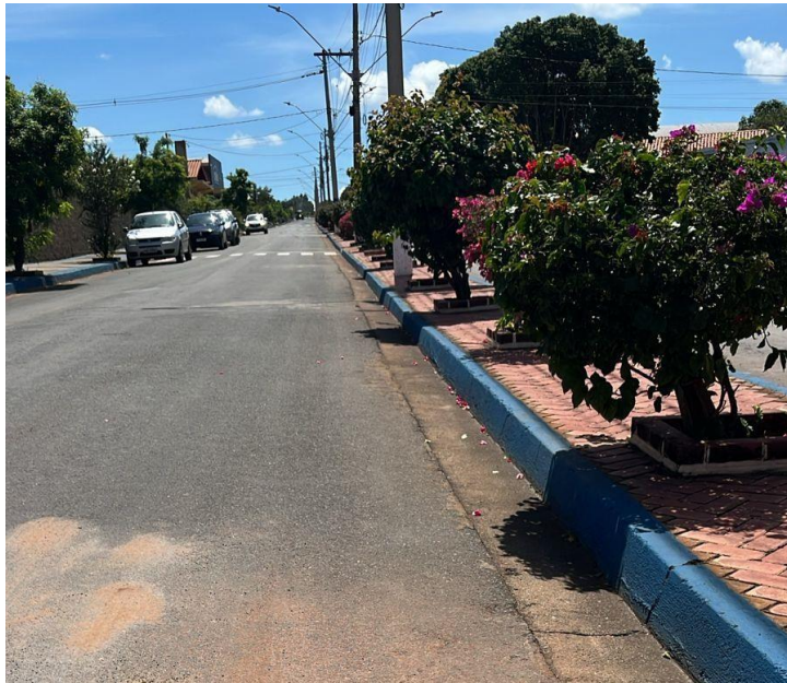
Figura 28: Canaleta de drenagem pluvial.
